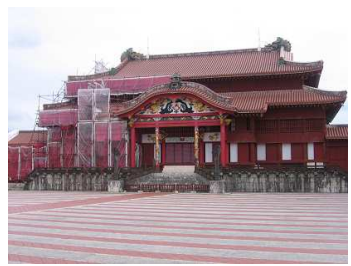
お城の中には案内の方がいて、色々説明してくれます。(補修工事が入っていました。)
